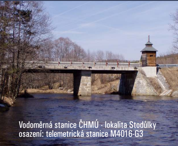
Kombinovaná srážkoměrná a vodoměrná stanice doplněná o měření teploty vody a vzduchu.
